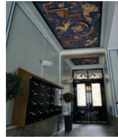
Brf Getebergsäng, Göteborg.
